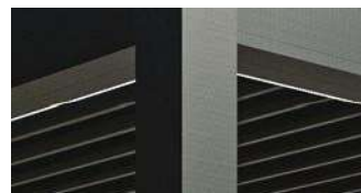
LED intégrée en caniveau
