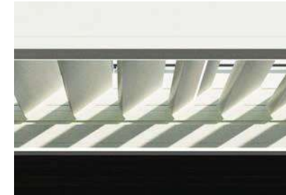
Contrôle solaire grâce aux lames orientables
